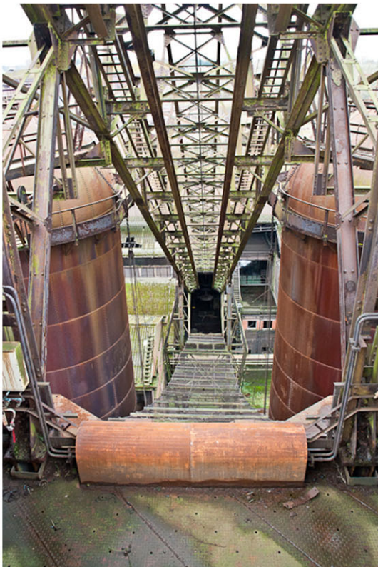
1) La rampe du monte-charge Staelher passant entre les deux cowpers. Vue prise depuis le plancher supérieur.
