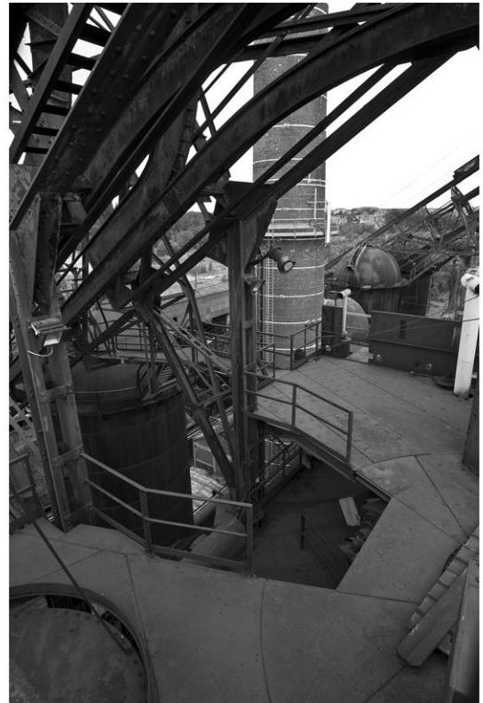
2) Toujours sur le plancher supérieur du haut fourneau. On remarque bien que les rails de guidage décrivent une courbe qui permet à la benne de venir se placer au-dessus du sas du gueulard. L'échancrure pratiquée dans le plancher permet le passage de cette benne. Sur le côté droit de la photo se trouve l'orifice du sas qui est recouvert par une tôle et des planches. A ce niveau se trouvent également les bleeders, soupapes de sécurité du haut fourneau dont l'ouverture est provoquée en cas de surpression dans la cuve.
